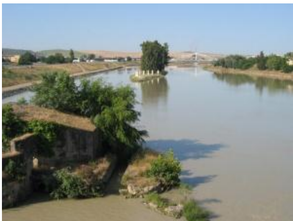
Vista del puente
