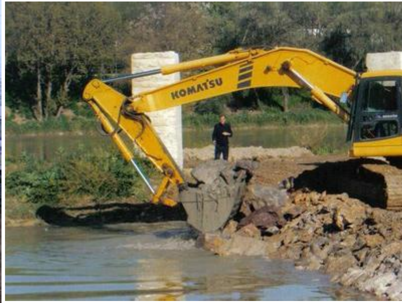
Construyendo un camino a la isla
