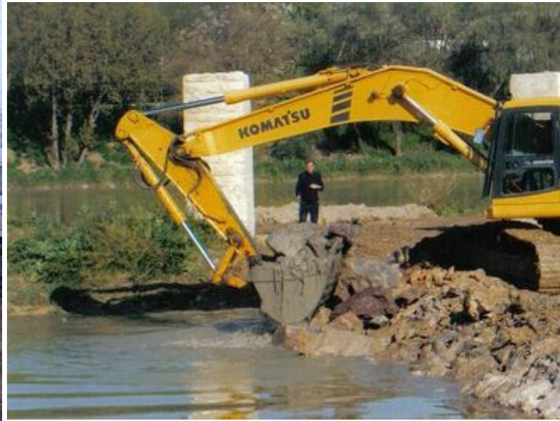
Wegebau zur Insel
